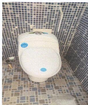
Foto 6: Sustrucción de sanitarios quebrados, por sanitarios nuevos y sus accesorios.
